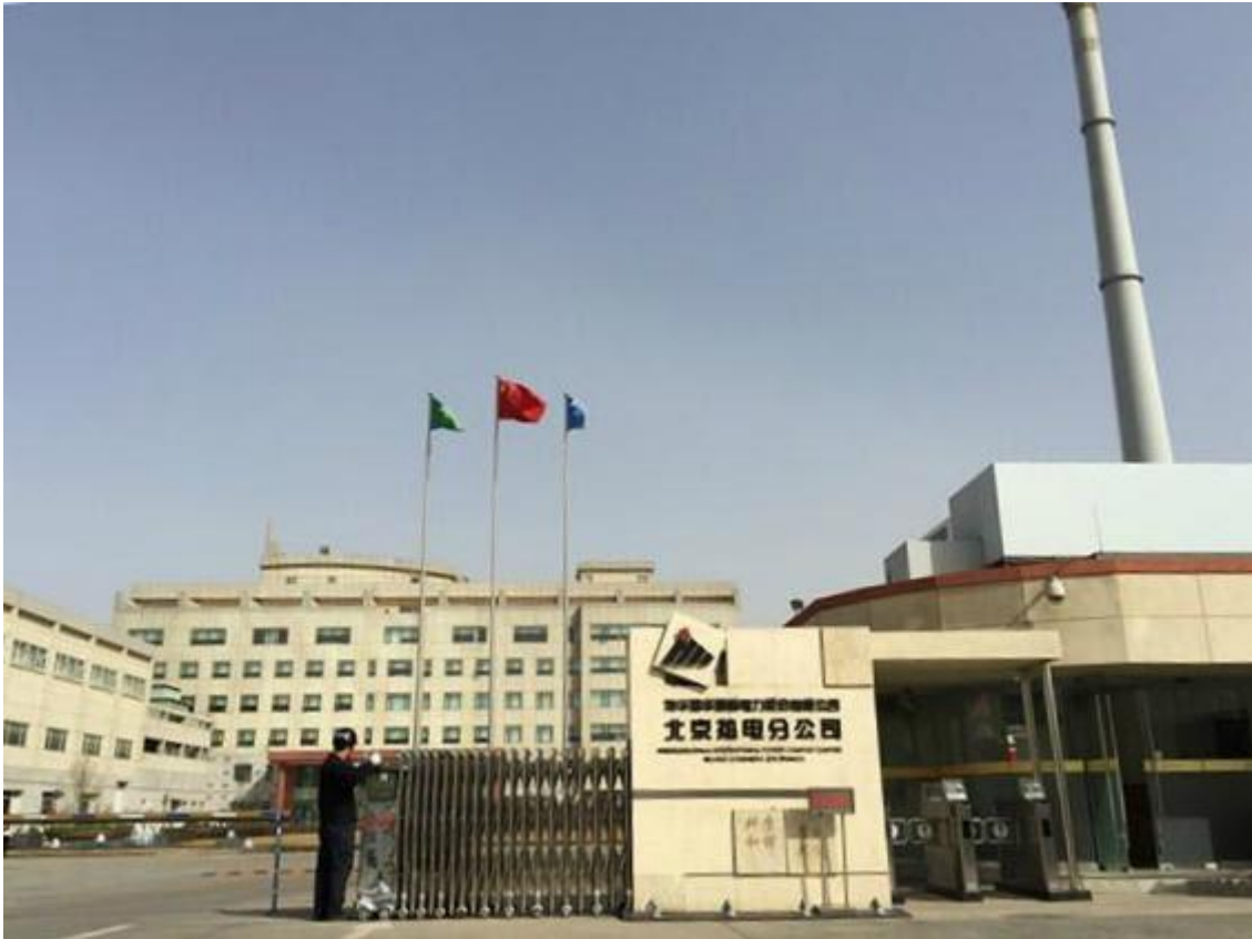
Рис. 18. Пекінська вугільна електростанція Guohua, Пекін
